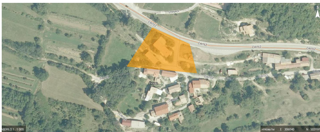
Slika 15:Lokacije klizišta u Čiritežu gdje je ugrožen stambeni objekt
